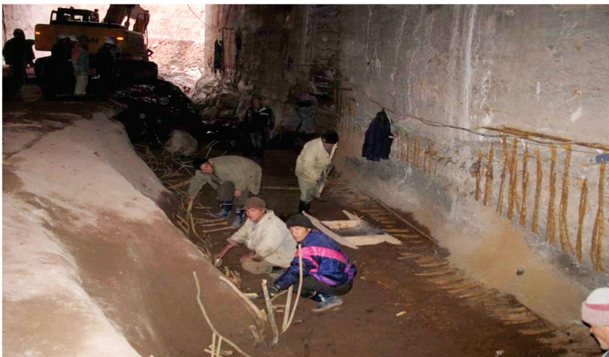
Рисунок 1. Размыв лотка I-го строительного туннеля
