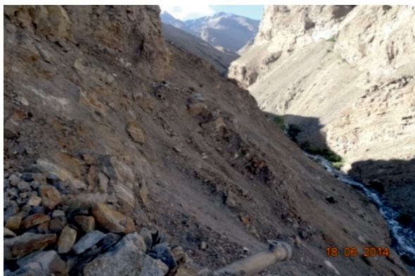
Рисунок 9-10. Разрушенная часть канала по правому борту сая Занудждара в результате активизации оползня. Автор фотографии Гоибназаров А.
