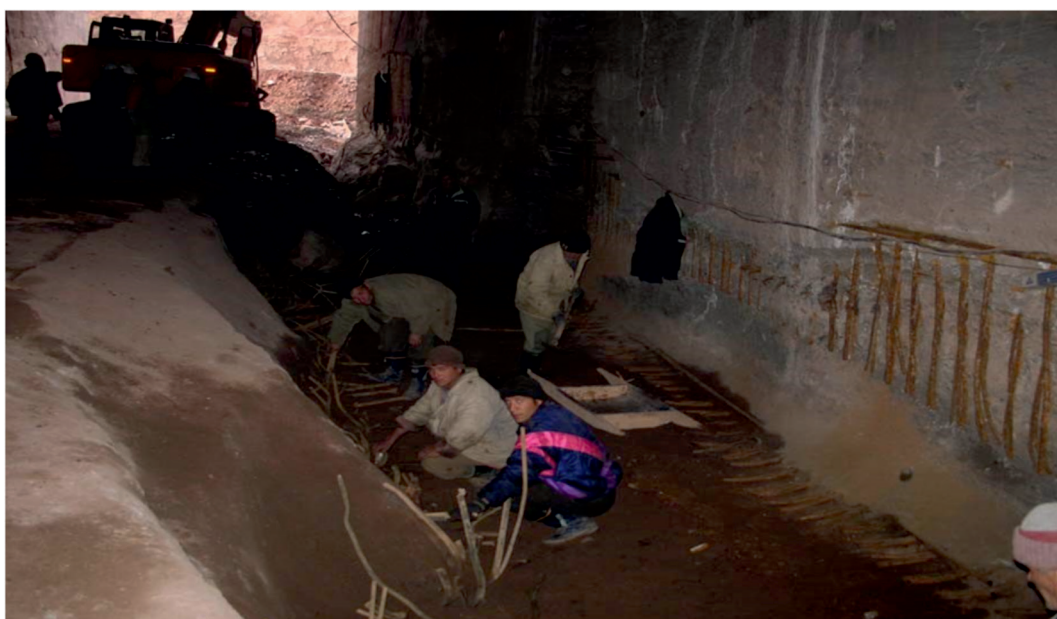
Рисунок 1. Размыв лотка I-го строительного туннеля
