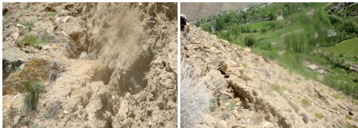
Рисунок 3. Проложенный без гидроизоляции земляной канал Вездара-Минденвед, который является главным фактором образования техногенного оползня. Автор фотографии Шафиев Г.В.
