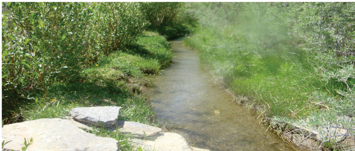
Рисунок 3. Проложенный без гидроизоляции земляной канал Вездара-Минденвед, который является главным фактором образования техногенного оползня. Автор фотографии Шафиев Г.В.
